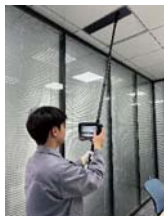
inspection des conduits de plafond
