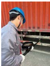
inspection du dessous de caisse
