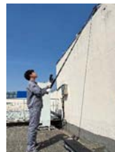
inspection de la toiture
